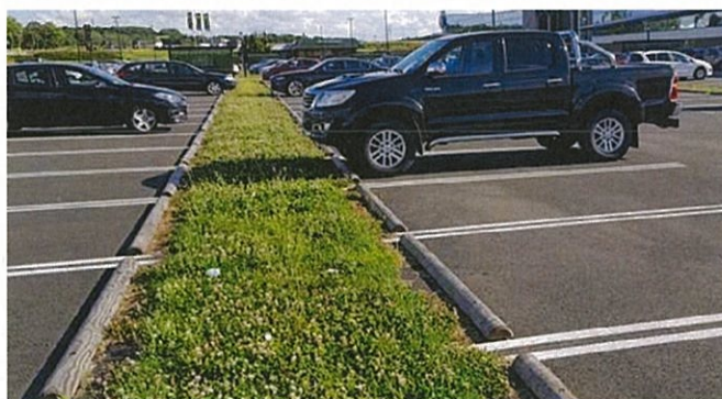
Exemple d'espace vert infiltrant entre les places de parking
